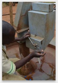
Le TokenTap facilite le modèle où les consommateurs paient pour l'eau, assurant ainsi la couverture des coûts d'exploitation et de maintenance tout en favorisant des transactions transparentes et équitables. Toutefois, il ne s'agit pas d'un concept nouveau, puisque plusieurs solutions de prépaiement de l'eau sont disponibles sur le marché.
