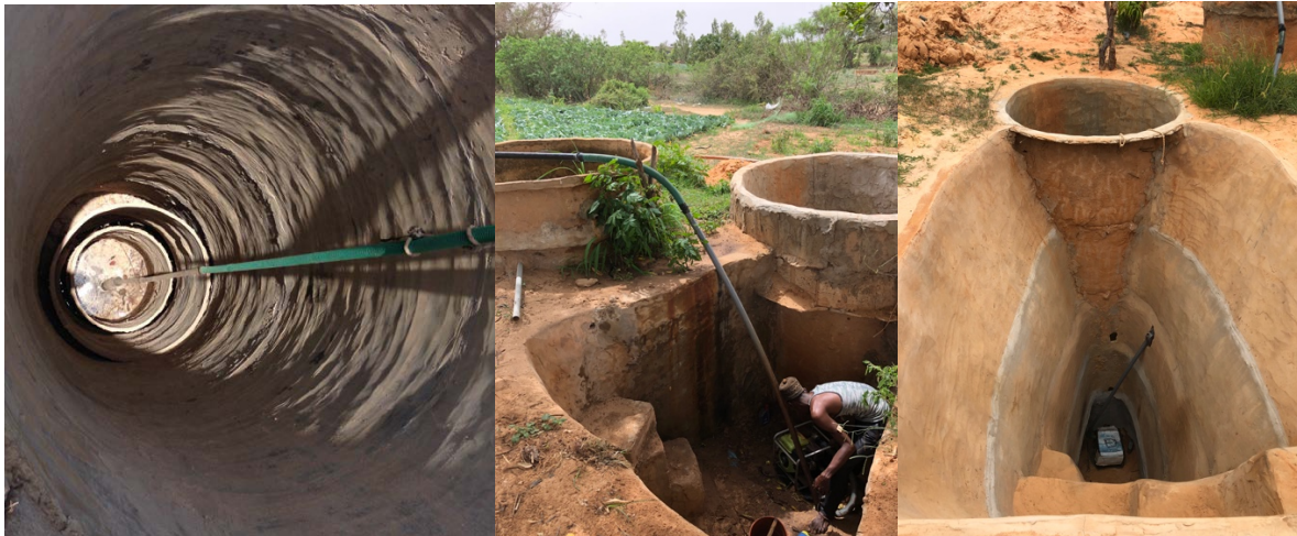
Figure 3 Puits profond peu productif avec une motopompe, motopompe et contre puits, contre puits
