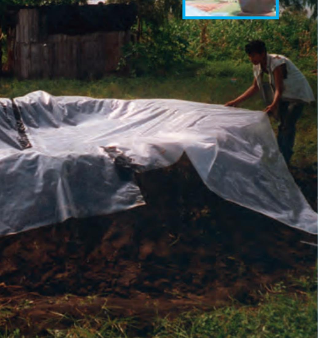
Los tanques con revestimiento plástico pueden ser una alternativa de bajo costo para los tanques de hierro y cemento.
