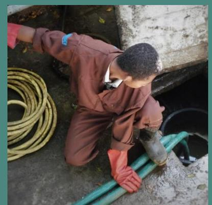
**Fig.3** Vidangeur d'une fosse septique
