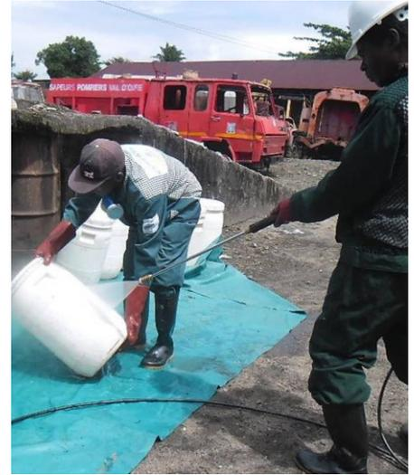
Fig.6 Station de nettoyage des fûts
