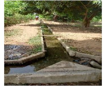
Dérivation des canaux en béton armé (principal et secondaire)
