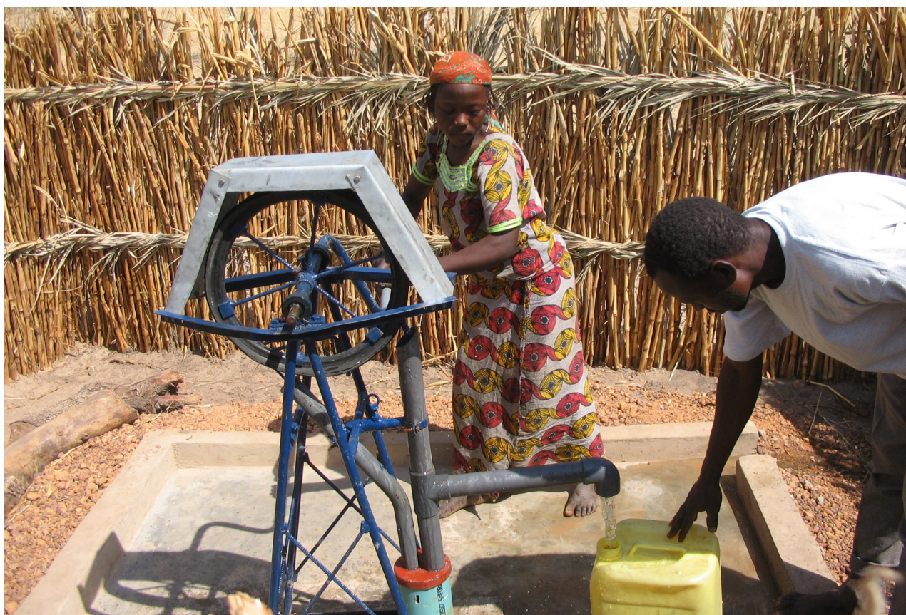
Forage manuel équipé d'une pompe à main de fabrication locale
