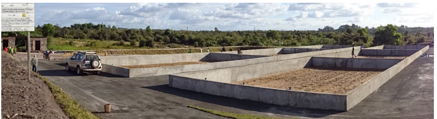
Fig.6 Station d'humification des boues de vidange de Tamatave (Madagascar) construite par Protos et Practica (juillet 2016)
