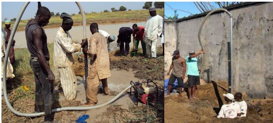
Figure 4. Forage au lançage à l'eau : le washbore
