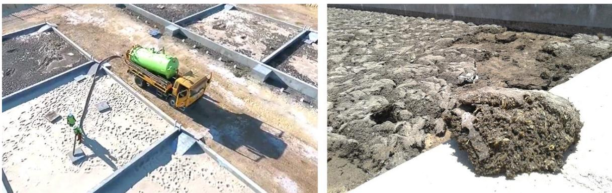
Figure 11 : Aperçu des lits de séchage (STBV de Majunga), et des biosolides (Source : Gescod et SIA/Practica)
