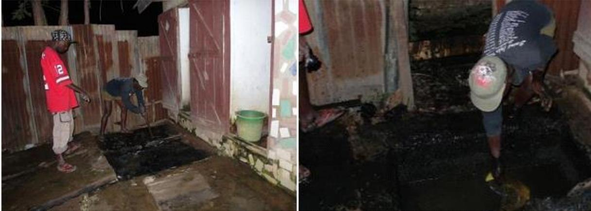
Figure 4 : Vidange et rectification d'une fosse septique par un agent de la CUF (Source : SIA, Practica).
