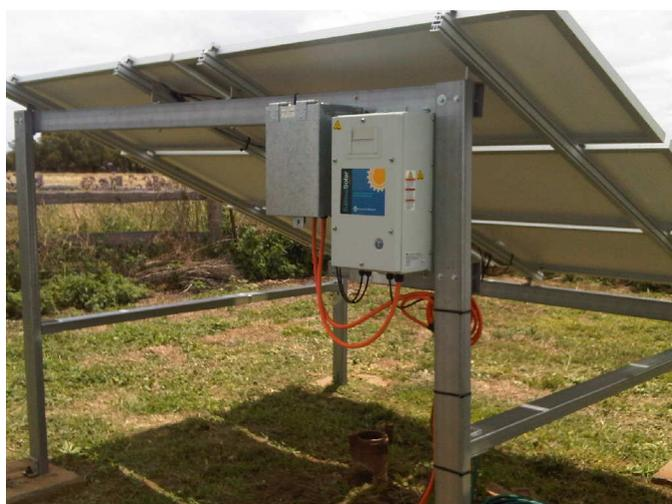
L'option la plus sûre est de loger les boîtes de contrôle dans un abri verrouillé, voir le schéma ci-dessous ou à l'intérieur d'un bâtiment.
