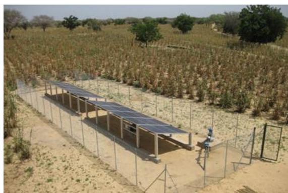
L'autre option est l'installation au niveau du sol, à proximité du forage. Le terrain devra être clôturé, pour protéger les panneaux et l'aire de captage du forage. La clôture devra, cependant, être un peu plus grande et plus résistante. Les avantages de cette installation sont la facilité de l'entretien, de la réparation et du nettoyage des panneaux.
