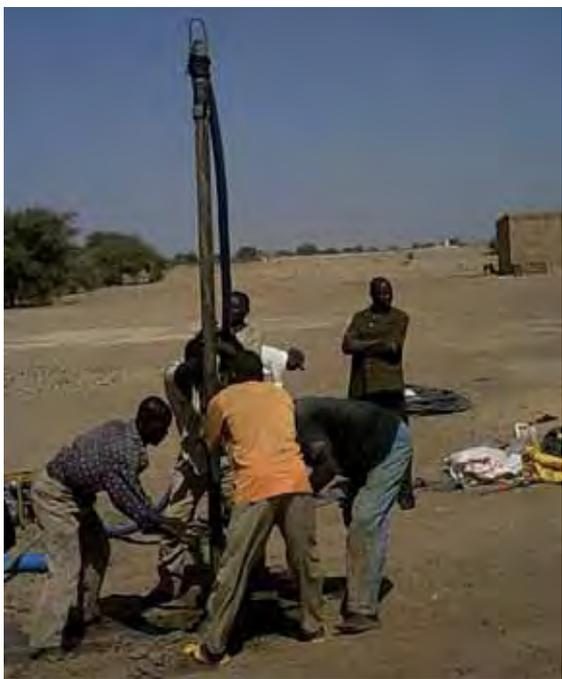
Le nom **lançage à l'eau ou jetting** vient de 'l'évacuation des débris de sol par l'effet lavant d'un jet d'eau lancé sous pression dans le trou du forage'. Cette technique est aussi dénommée technique de forage au 'washbore' ou encore 'rotary manuel' du fait du mouvement de rotation transféré par le manche au train de tiges (ou allonges) pour permettre de briser et couper les particules de sol.
