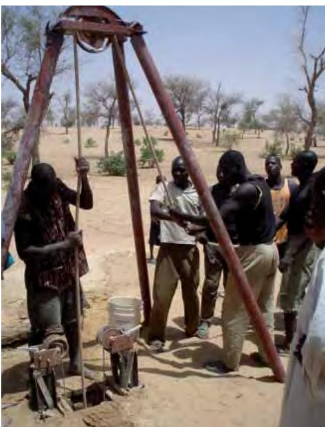
**LE FORAGE A LA PERCUSSION** utilise un lourd trépan (ou cuiller) attaché à une corde ou un câble, lequel est descendu dans le trou du forage ou à l'intérieur d'un pré-tubage. Un trépied (ou chèvre) est en général utilisé pour suspendre l'équipement. En actionnant la corde ou le câble de haut en bas, le trépan ameublie et fragmente le sol ou la roche consolidée dans le trou de forage, dont les débris sont ensuite extraits grâce à la cuiller.
