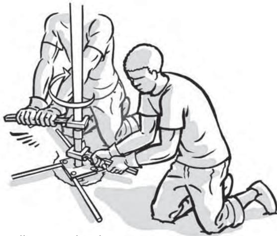
Assembler cette nouvelle allonge sur celle qui est dans le trou du forage.
