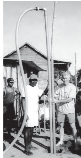
**Avec la technique du lancement à l'eau rotatif ou rotary manuel**, les forages réalisés peuvent être plus profonds qu'avec la technique du lancement rapide à l'eau. Elle est généralement utilisée pour des forages destinés à l'eau potable.
